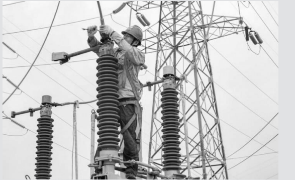
图为国网陕西电力工作人员在110千伏贾村变电站更换隔离开关刀闸。
