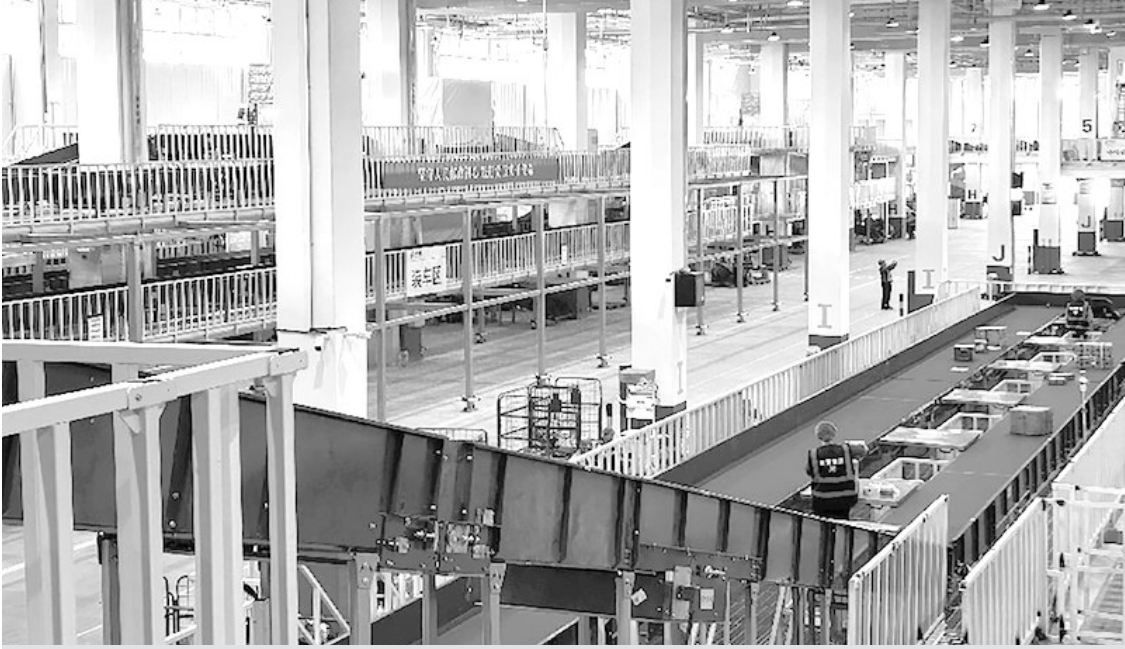
日前,中国邮政西安邮件处理中心项目(二期)——西安邮区中心陆港中心投产试运行。该项目位于西安沣沪国际港,总建筑面积约5万平方米,设计日均处理能力达248万邮件。
