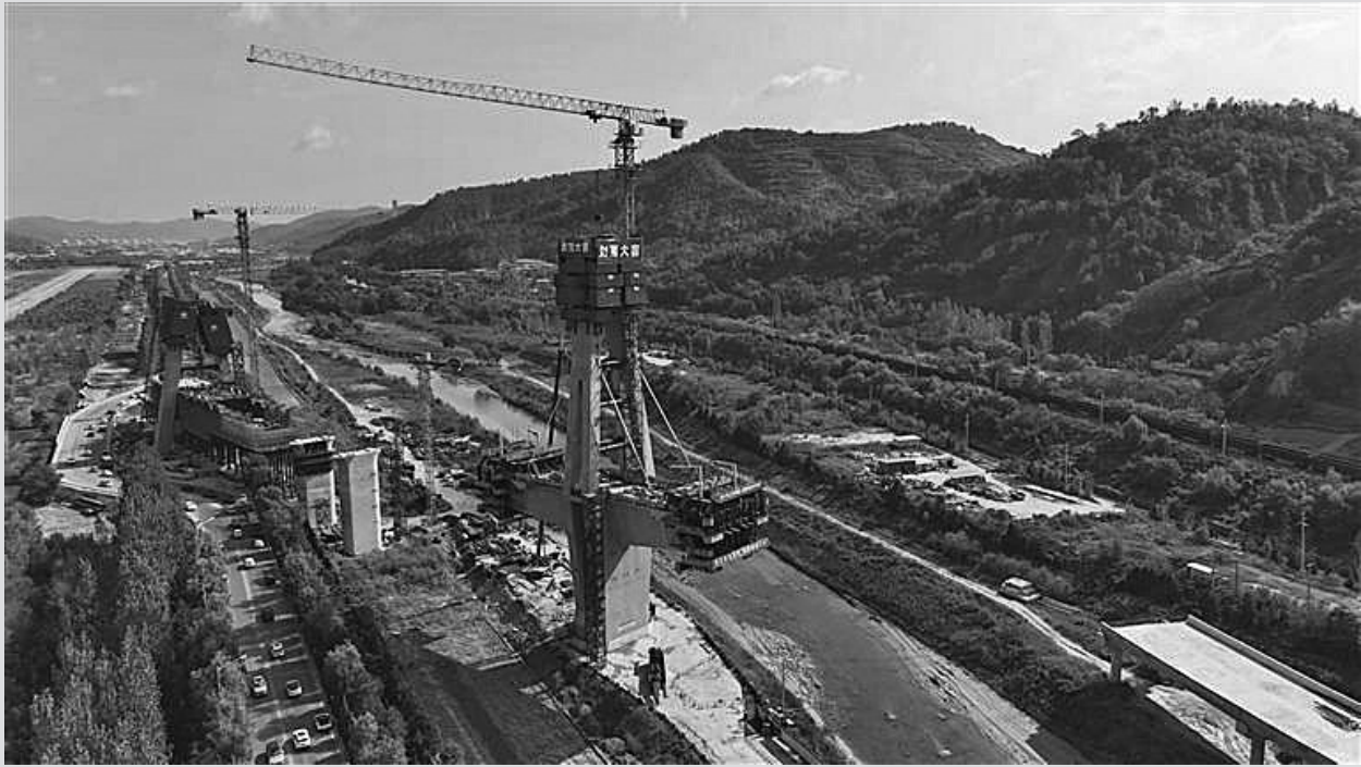
图为封顶前最后一斗混凝土平稳入模。
