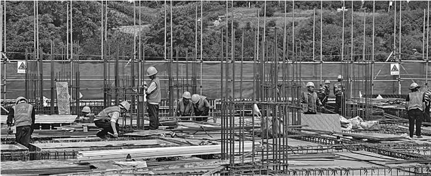
8月2日,汉阴天石汇汽车运动文化产业园建设项目(一期)施工现场,各道工序有条不紊地推进项目加快建设。王磊摄
