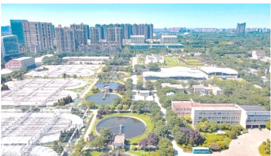
西安水务集团净水处理有限公司第三再生水厂。
