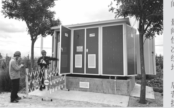
当日,现场工作人员对高压开关柜、变压器、计量装置等设备进行细致检查与绝缘测试。随着合闸指令的执行,崭新的电力设施平稳启动,计量点位数据精准回传,标志着一次性送电圆满成功。此次高效投运,为大桥的照明、监控及交通信号等系统提供了可靠保障。该公司用可靠的电力支撑为地方经济高质量发展注入强劲动能。
