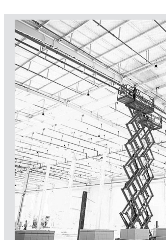
近日,位于三原高新区的三原泰龙物流二期建设项目现场,工人正在进行厂房内部施工。近年来,三原县依托区位优势和产业基础,聚焦绿色食品加工、先进制造、生物医药、现代商贸物流等重点产业,持续做优做强主导产业和特色产业,推动县域经济高质量发展。 何城城 摄
