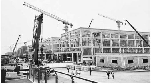
西凤酒10万吨优质基酒及配套生产项目施工现场。
