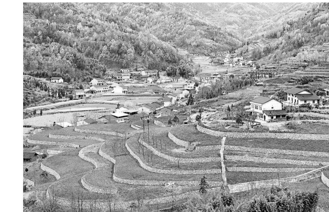
安康市汉滨区大河镇抢抓春耕有利时机，组织实施坡改梯标准化农田建设，让山间的“石坎坎儿”成为稳定粮油增收的“金碗碗儿”。图为该镇兴红村连片320亩标准农田建设一角。 陈均威 摄
