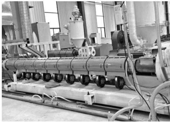
正在建设的螺旋钢管防腐保温涂层加工项目车间。
