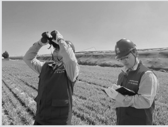
国网陕西电力工作人员对春耕春灌用电线路进行巡视。
