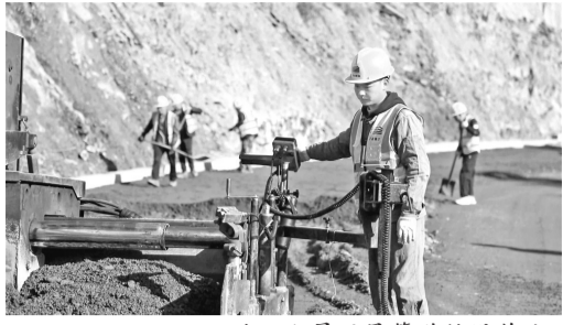
施工人员开展管道铺设作业。
